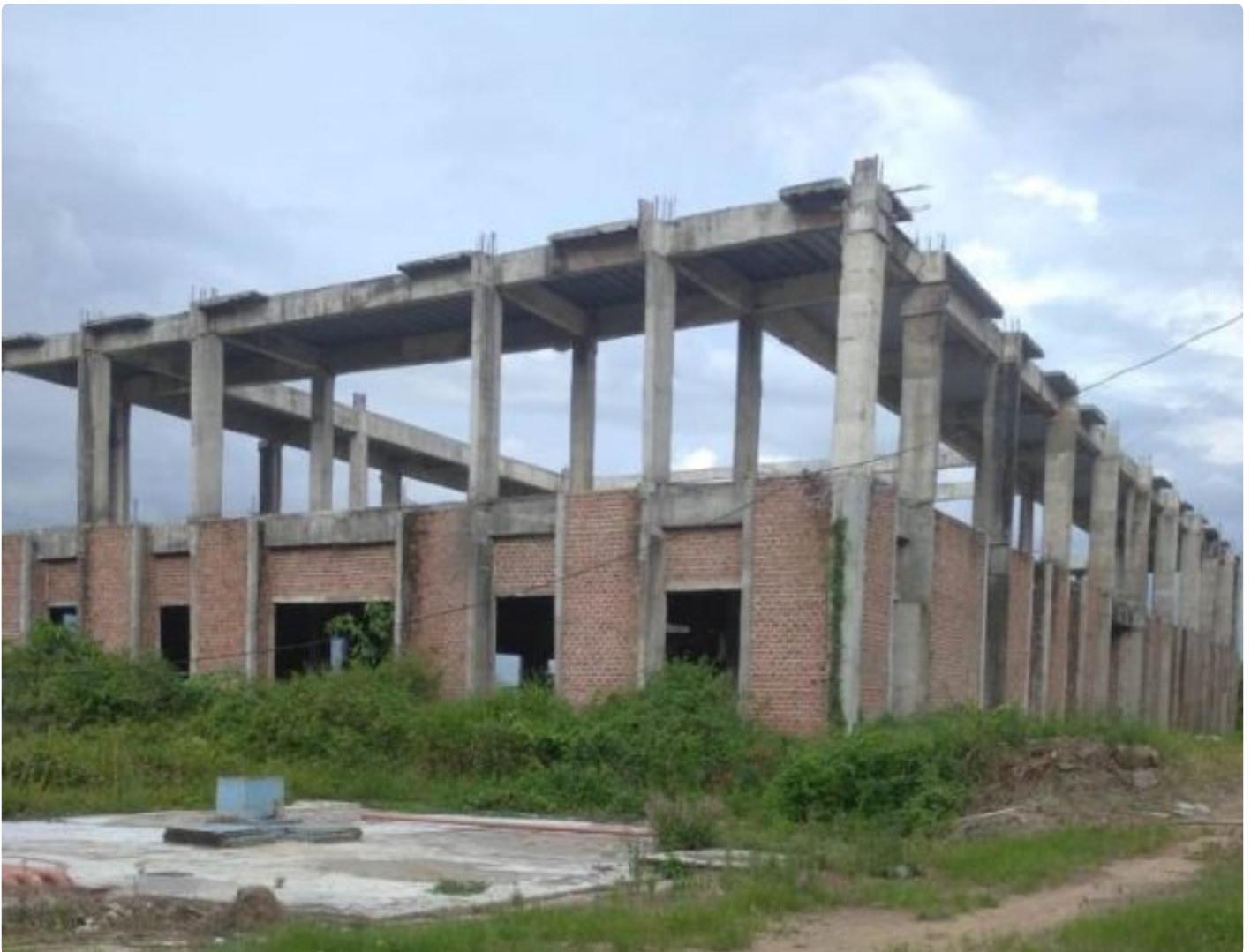
Gedung Kantor Sekda Gedung C Tahap II Kabupaten Pesawaran
